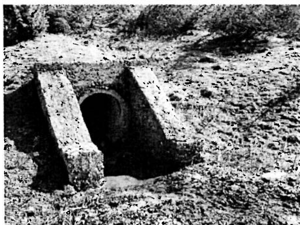
Водосток на път III-865
