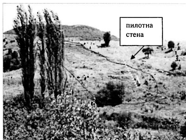
Изглед от свлачищния участък, юли 2017 г.
